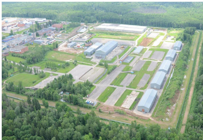
Рис. 24. Сооружение 103 на площадке ФГУП «РАДОН»
